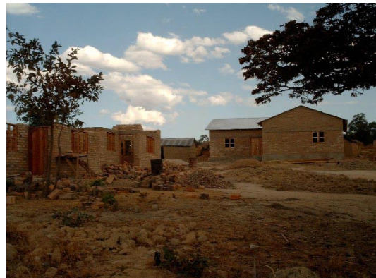
Obras de construcción del dispensario y casas
