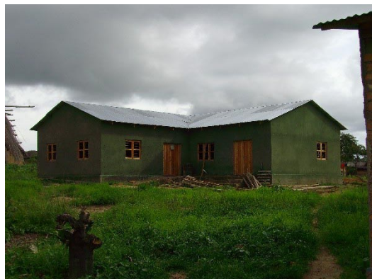
Estado actual del dispensario (enero 2007)
